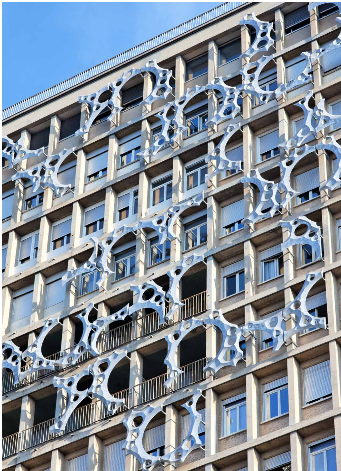
Hôpital Nord, L'Ecume des Jours, Marseille, France, 2013
